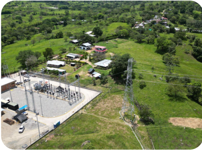
IMAGEN 4 - SUBESTACIÓN SEGOVIANAS AT/MT LA PLATA (H)
